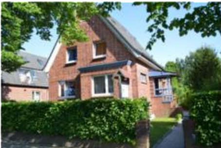
Ansicht Haus (Straßenansicht)
